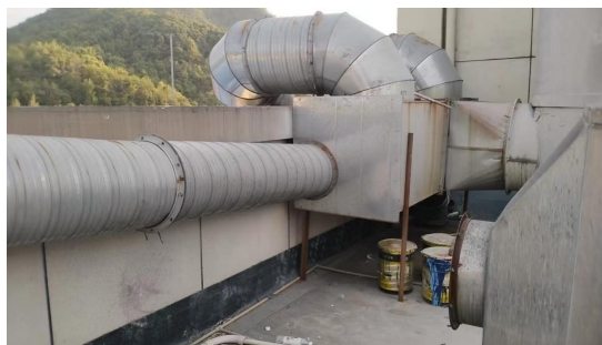
喷漆废气进口和烘干废气进口连接处
