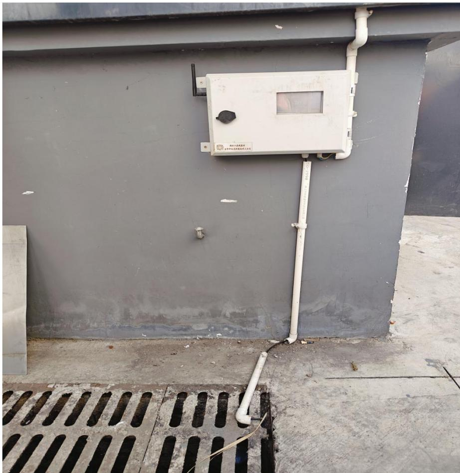
雨水口设置电导仪
