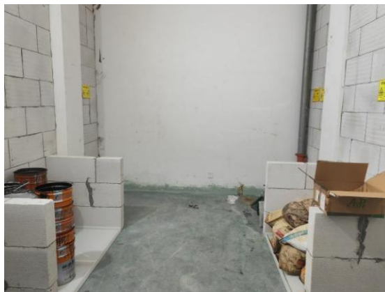
图 4.1.4-2 危废仓库（内部）
