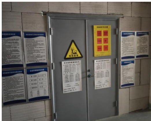
图 4.1.4-1 危废仓库（外部）
