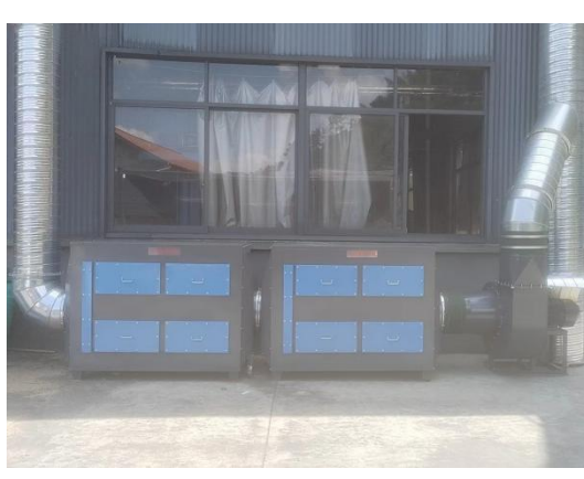
上胶、液压废气处理设施及排气筒（DA002）
