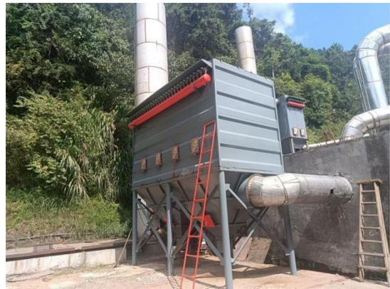
烘干、生物质燃烧废气布袋除尘器
